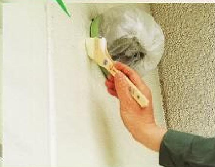
まずは、ローラーバケでは塗りにくい部分から塗装します。マスキング処理での塗り分け部分や、養生をした部分のまわり、凹角などはスジカイバケを使うなりして、先に塗っておきましょう。
