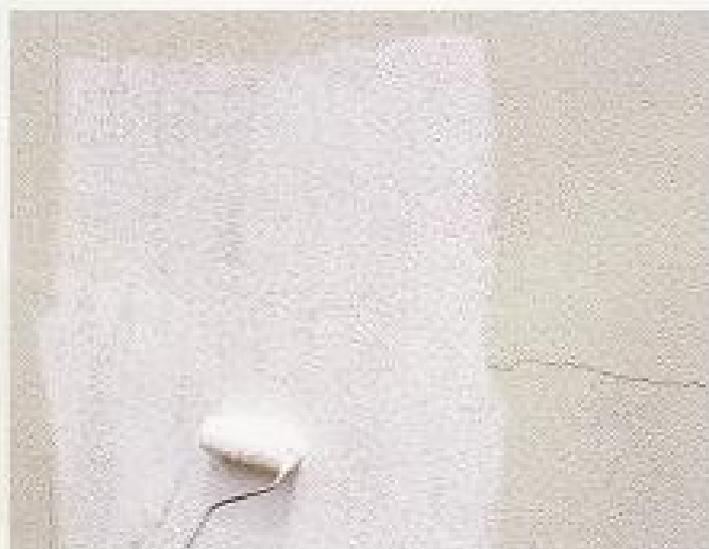
基本的には、いったん壁にM字型にシーラー（フィラー）を塗り置き、次にその隙間を埋めていく感じでゆっくりと塗り伸ばします。塗る面からローラーバケが浮くとムラになるので、丁寧に動かします。
