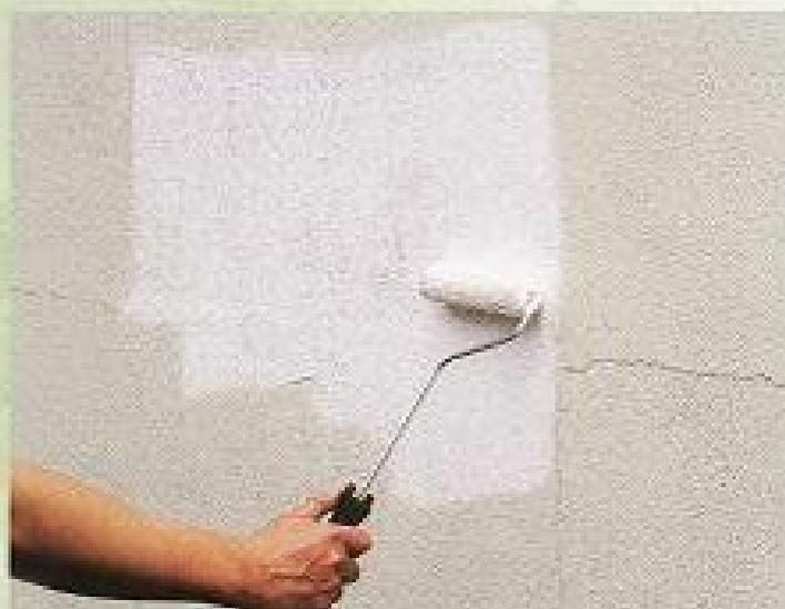
シーラー（フィラー）は壁全体に塗っていきませんが、クラックを補修した部分は特に念入りに塗ります。ローラーバケは「下から上」に向けて、毛に含んだシーラー（フィラー）を押しつつ、押し伸ばす感じで。
