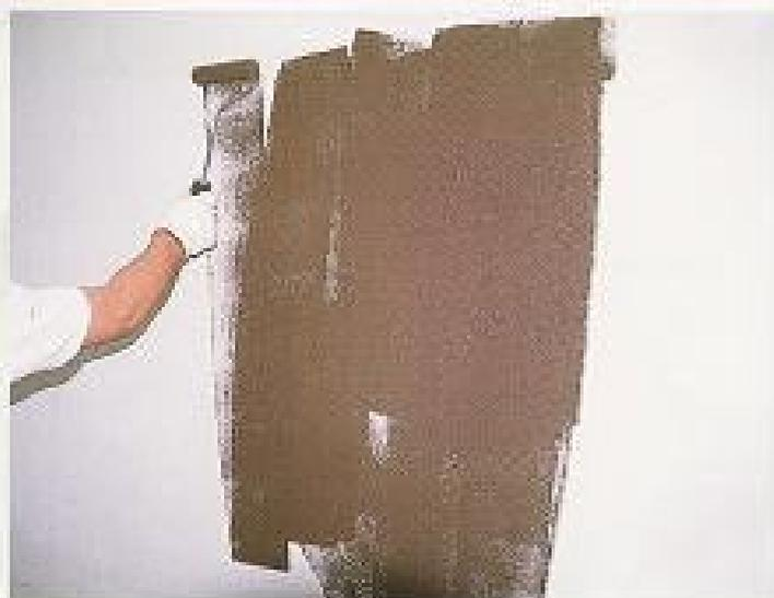
塗り方の基本を思い出しながら、モルタル壁の凹凸にしっかり塗料が乗るよう、ゆっくりローラーバケを動かしましょう。写真のように左側方向に向かって塗り進めていきます。
