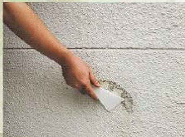
鉄部のサビはワイヤーブラシやサンドペーパーで落とし、はがれそうな浮いた塗膜は皮スキではがして、サンドペーパーで下地を整えます。また、外壁のはがれかかった塗膜は皮スキやヘラでそぎ落とし、家庭用セメントや弾性シーリング材で下地を整えます。
