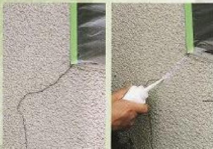
窓枠の角などもクラックが入りやすい部分です。同じように弾性シーリング材でしっかりと充填していきます。うまくテクスチャーをなじませて、補修のあとが目立たないようにしましょう。
