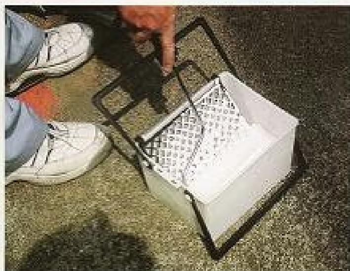
ローラーバケをシーラー（フィラー）の液面に浸けて、バケットの網で「下へ向かって」練り返ししごき、なじませます。ローラーバケを持ち上げて、塗料がポタポタ落ちない程度がちょうどいい含み加減です。
