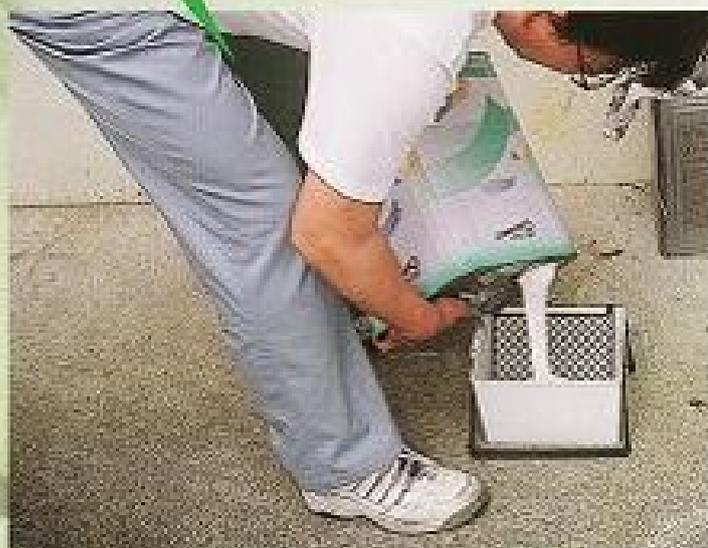
まずはローラーバケットに1/3程度の量のシーラー（フィラー）を注ぎ入れます。シーラー（フィラー）はカタログの希釈割合を参考に、水を加えて攪拌します。
