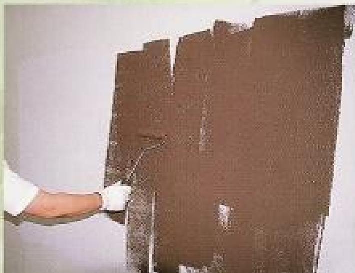
このようにM字の隙間を埋める感じにローラーバケを使って塗装します。最初のうちは家の裏手に面した、手の届く部分から始めて、慣れてきたら玄関側や高所部分にチャレンジしていきましょう。
